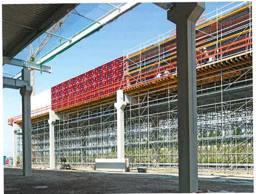
Komplettlösung aus einer Hand: Wand- und Deckenschalungen sowie Trag- und Bewehrungsgerüste waren optimal auf die Projektanforderungen abgestimmt.
